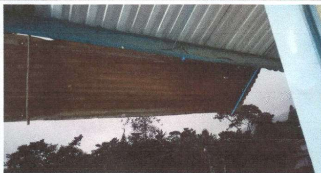
Foto 1. Sustrucción de lámina, por lámina troquelada Alucin calibre 26 + Sustrucción de elementos de fijación + Sustrucción de estructura de soporte de metal, por metal
