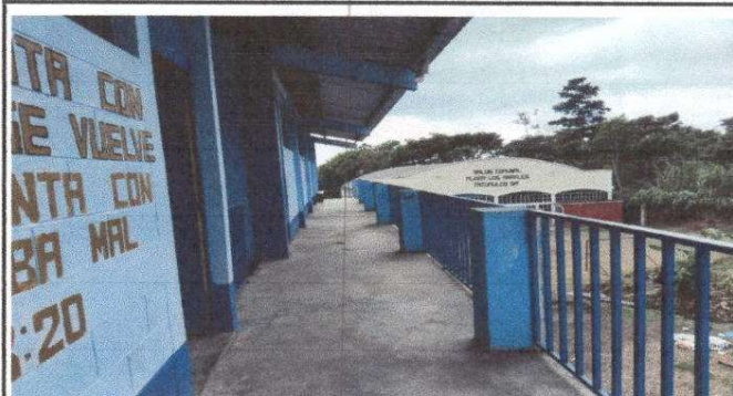
Foto 4. Mantenimiento a barandas de metal
