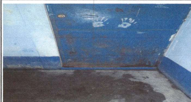
Foto 2. Mantenimiento a estructura (lijado, cambio de tubo, cepillado, sujeciones, aplicación de pintura) + Sustrucción de chapa
